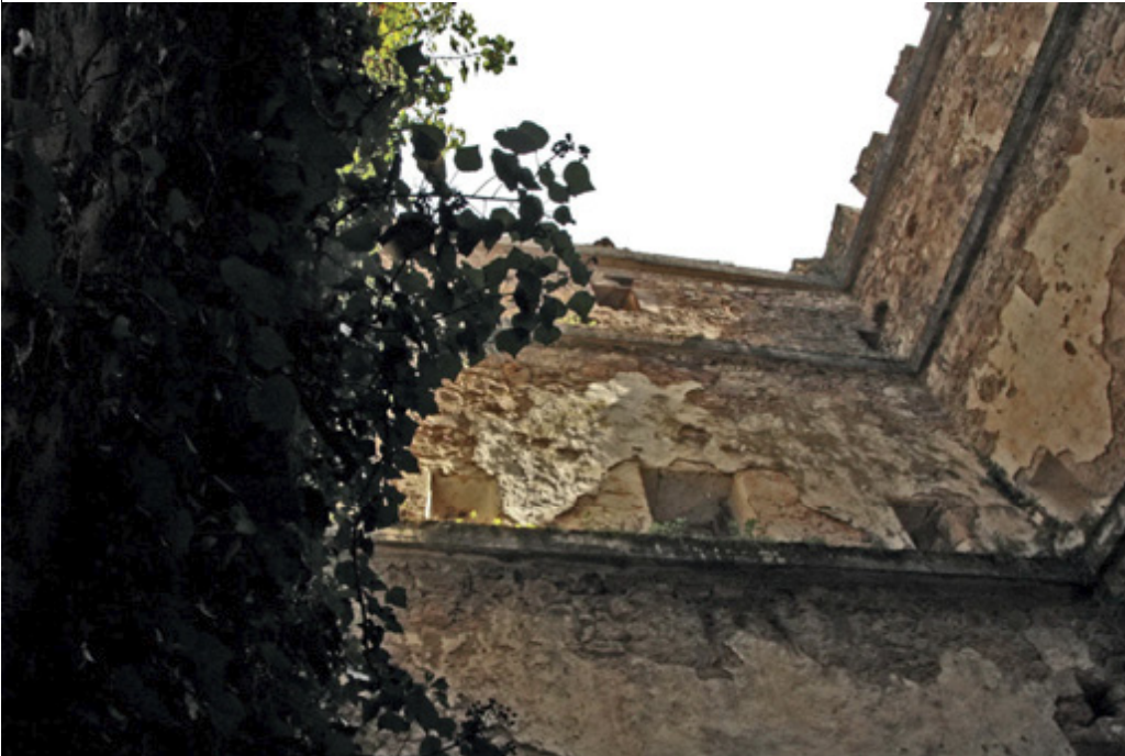
Estado del interior de la torre (detalle)
