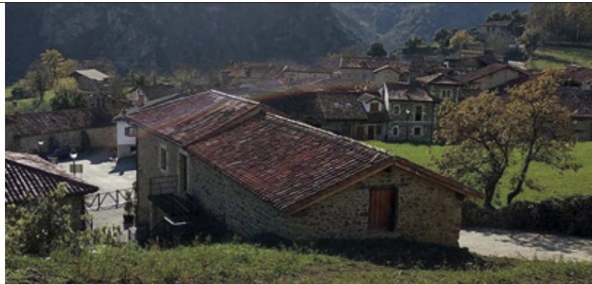
Vista de fachadas norte y este
