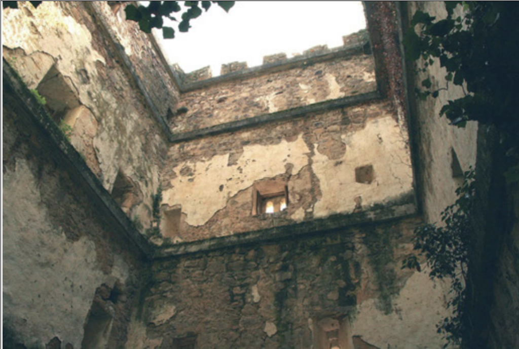
Estado del interior de la torre (detalle)
