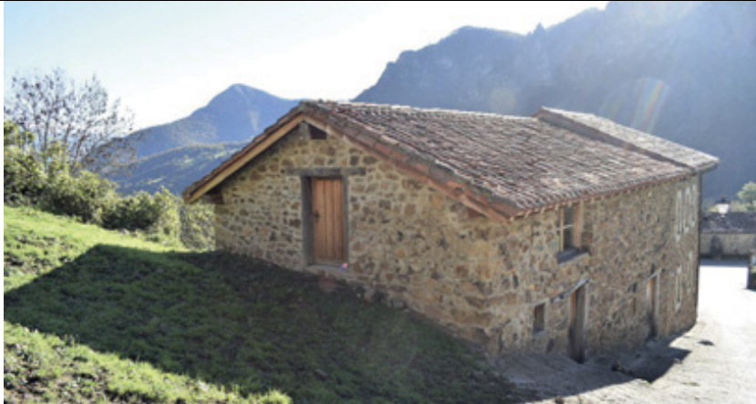
Vista de fachadas norte y oeste
